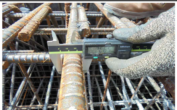
철근 배근 현황
