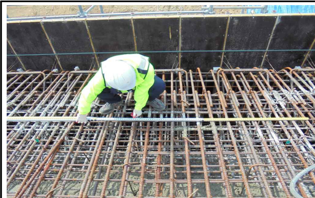
철근 배근 현황
